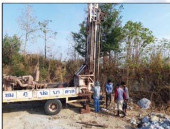
รูปที่ 12 ภาพการเจาะสำรวจแบบเก็บเกล็ดตัวอย่างหินที่หลุม BH-2
