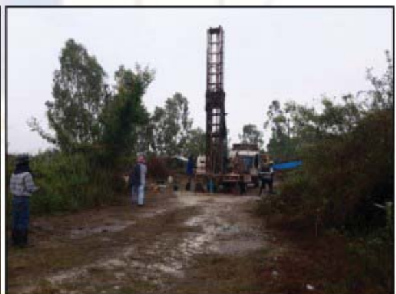
รูปที่ 13 ภาพการเจาะสำรวจแบบเก็บเกล็ดตัวอย่างหินที่หลุม BH-3
