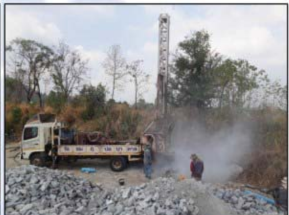
รูปที่ 12 ภาพการเจาะสำรวจแบบเก็บเกล็ดตัวอย่างหินที่หลุม BH-2
